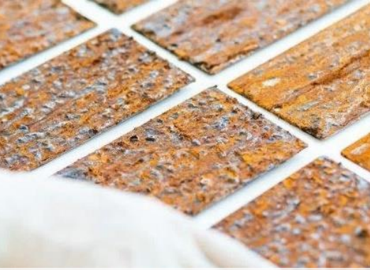
Korrosionsprüfung nach Maß
