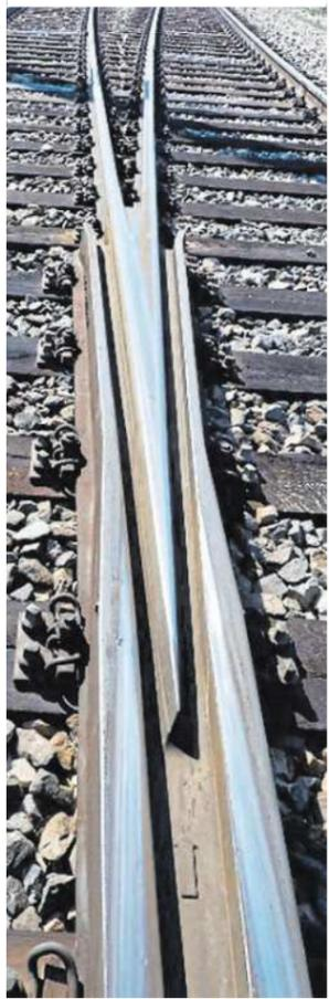
Das AC²T untersucht aktuell den Verschleiß an einem typischen Schienen-Weichenherz
